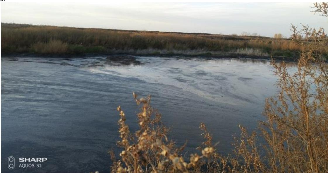
*Рис. 7. Состояние этой же иловой карты на сентябрь (полное устранение поверхностной иловой корки).*
