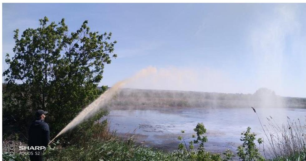
*Рис. 2. Внесение раствора препарата Экобактер на иловую карту поверхностным способом, при помощи автомобиля с гидрантом (пожарная машина МЧС).
