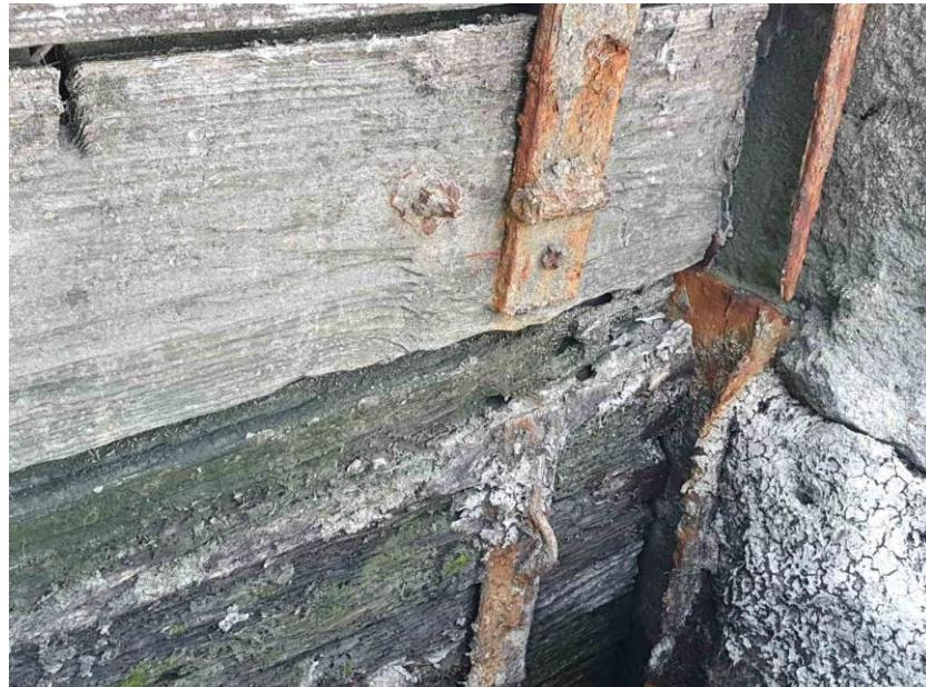
*Рис. 3 Конструкція дерев'яного затвору. Сильна корозійна агресивність металевих конструкцій затвору*
