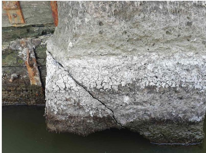
*Рис 2. Похила тріщина з наднормативним розкриттям. Бетонні конструкції мають біоушкодження*
